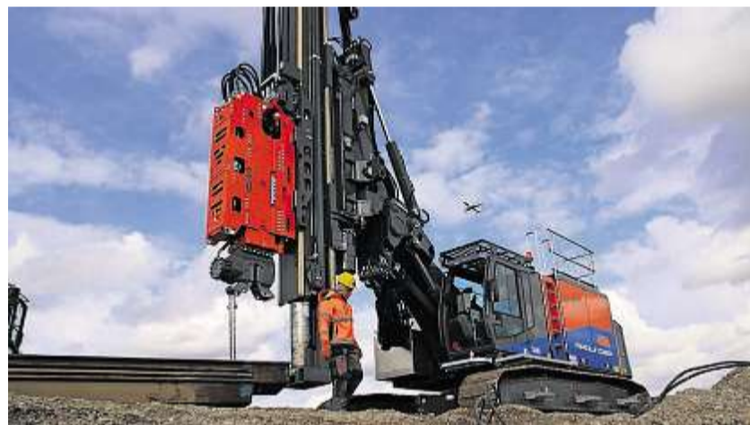
Die größte Präsenz zeigt das Unternehmen aktuell auf mehreren Baustellen am Flughafen München und spricht vom „größten Projekt seiner Geschichte“.
