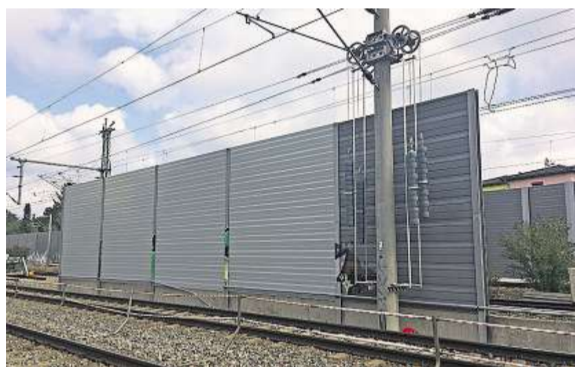
„Projekt Lärmschutz DB Obermenzing“: Hier entsteht eine Lärmschutzwand aus Aluminium und Acrylglas.
