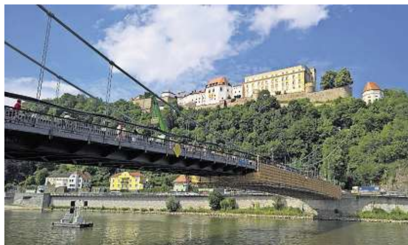
Sanierung eines Passauer Wahrzeichens: Die Luitpoldbrücke spannt sich seit 1910 von unterhalb der Veste über die Donau bis in die Altstadt. Fotos: Rädlinger
