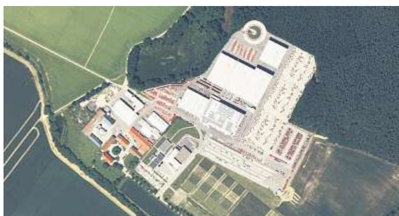
Die Firmenzentrale in Schwandorf aus der Vogelperspektive
