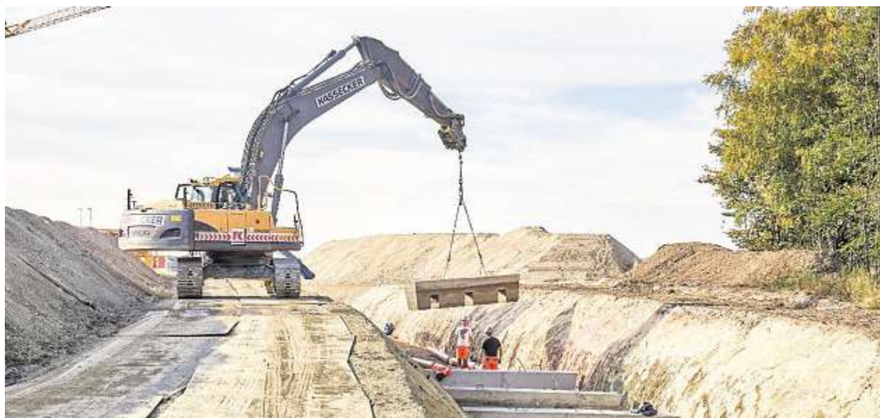
Der Graben ist ausgehoben und wird zum Flüssigbodeneinbau vorbereitet.
