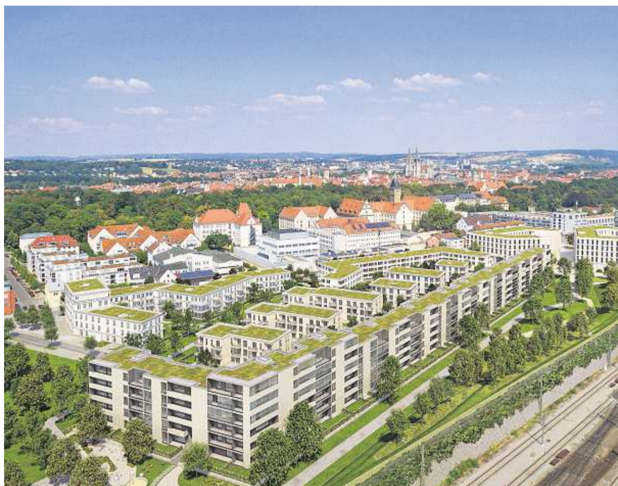
Im Dörnberg-Viertel werden innovative Ansätze der Quartiersentwicklung verwirklicht, wie zum Beispiel ein Elektromobilitätskonzept. Foto: Dörnberg-Viertel Projekt GmbH & Co. KG
