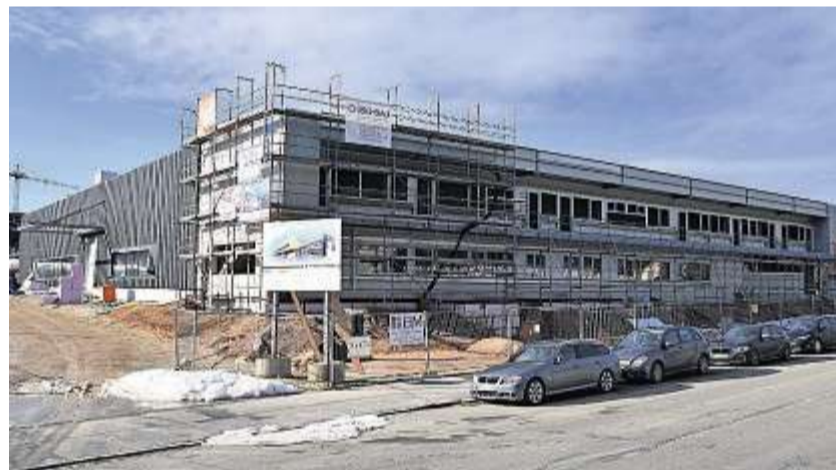
Für die Produktionshalle eines Unternehmens in Amberg mussten 70000 Tonnen Erdreich abgetragen und eine neue Infrastruktur errichtet werden.
