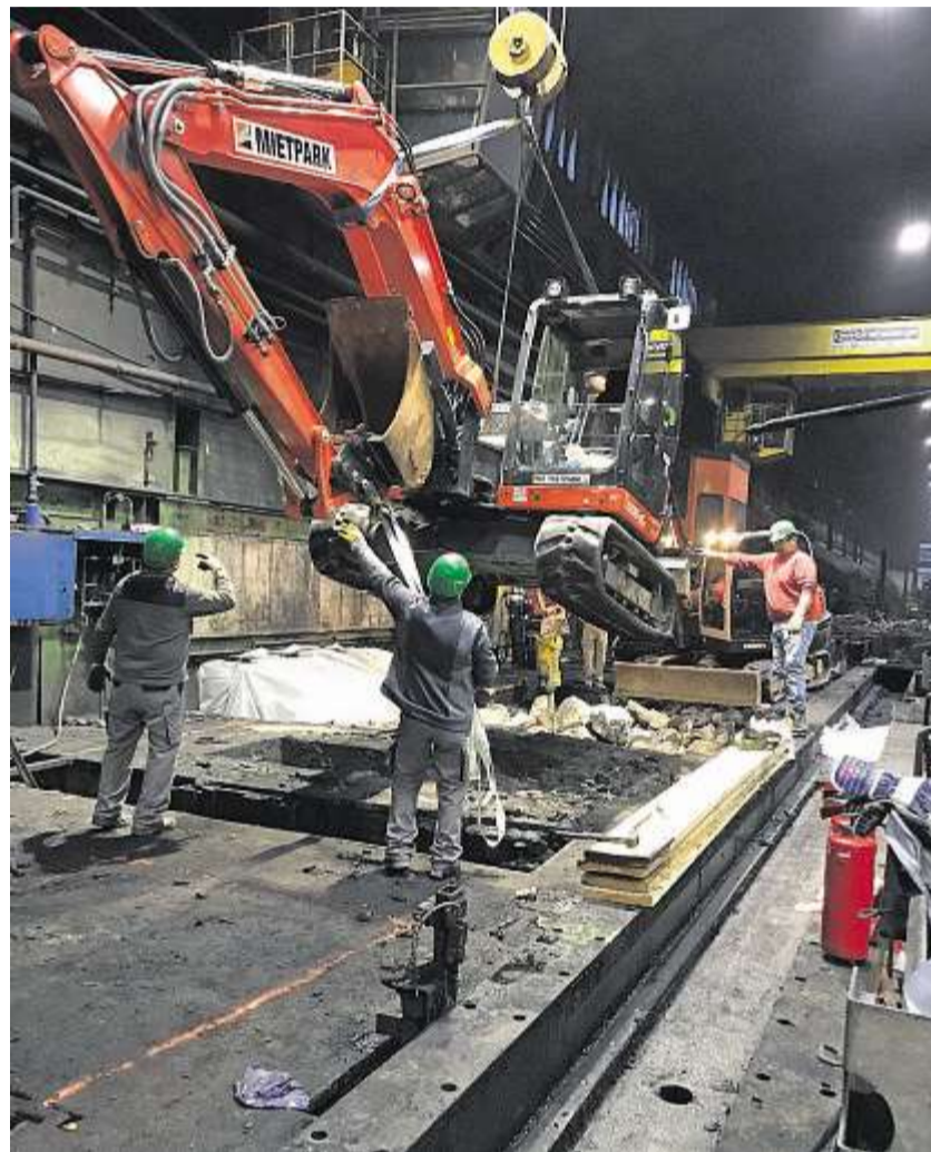
Im Rohrwerk Maxhütte wurde über Weihnachten unter Zeitdruck gearbeitet.
