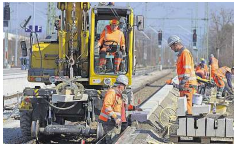
Verlegung der Bahnsteigkanten am Bahnhof Weilheim
