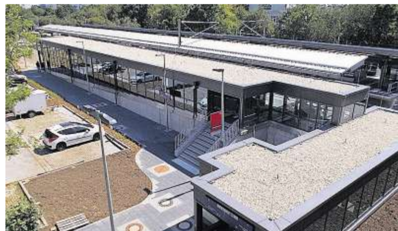
Neuer barrierefreier Haltepunkt in Unterschleißheim
