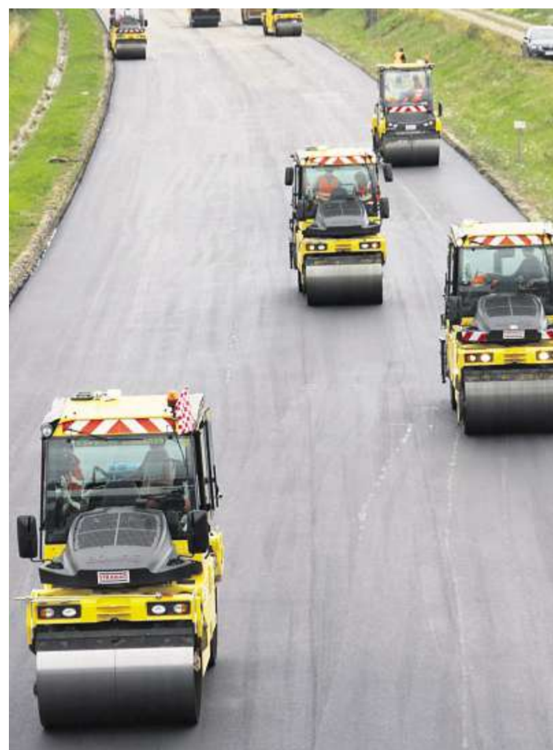
Für den Asphalteinbau kommen bei der STRABAG-Unternehmensgruppe vernetzte Walzen zur Steigerung der Einbauqualität zum Einsatz.
