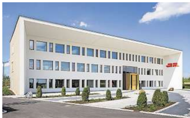
Verwaltungsgebäude der Josef Rädlinger Ingenieurbau GmbH
